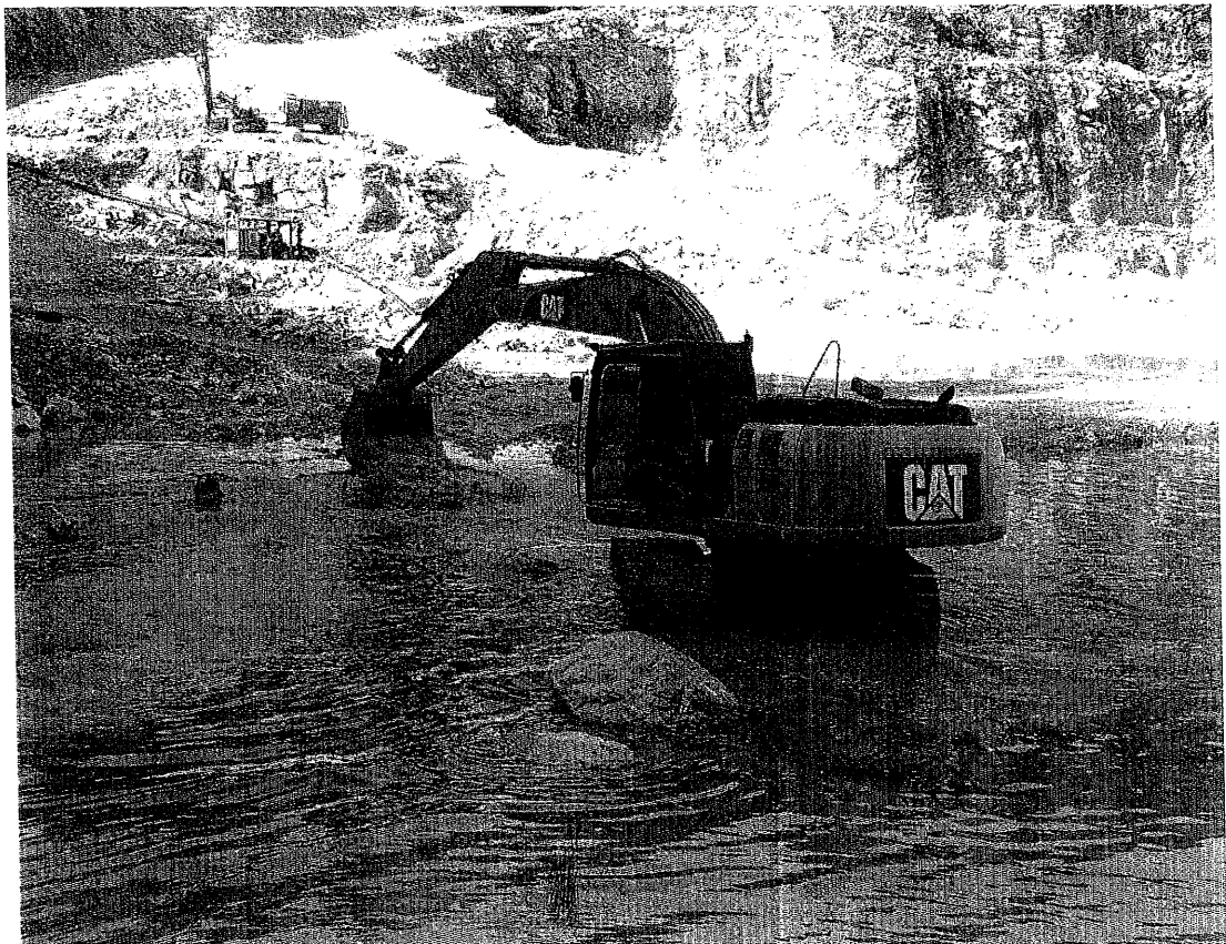
ภาพที่ 1.2 การขุดลอกปอดักตะกอน
